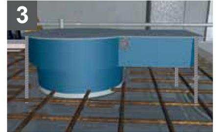
Leerrohr einführen. Oberteil einfach aufstecken. Außenhöhe 180mm - Innenhöhe 160mm
