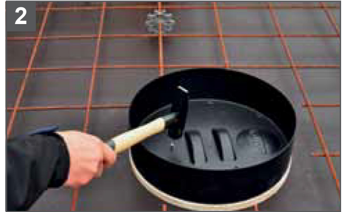
Unterteil auf Schalung nageln.
